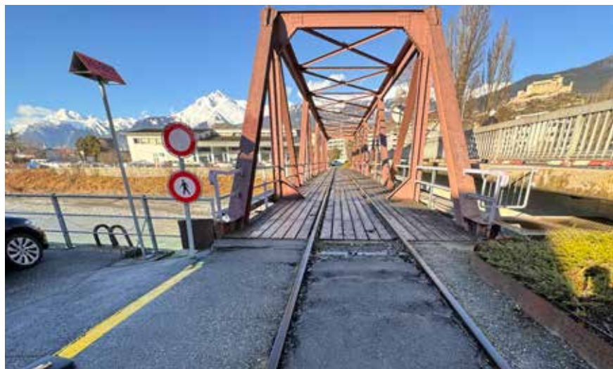
Image 1: Pont du Rhône avant l'installation des dalles STRAILgrid . Les piétons et les cyclistes ont pu traverser le pont librement.
