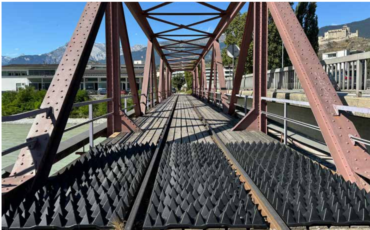
Image 3: Pont du Rhône après l'installation des dalles STRAILgrid plus possible de traverser le pont.
